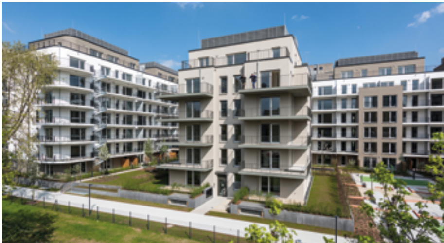
Saonestraße, Frankfurt am Main, Germany
